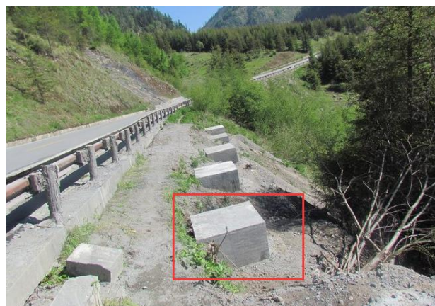
Estacas anti-deslizantes (totalmente abaixo da superfície)
